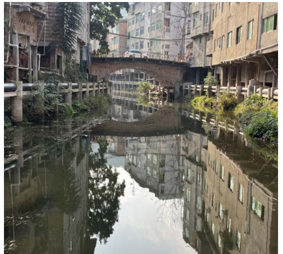
通山乡乡镇河段现状照片
