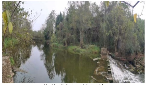
葫芦嘴堰现状照片
