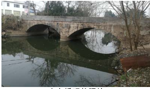
小东桥现状照片
