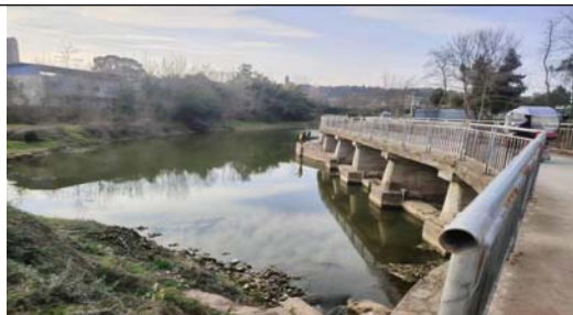
邓家堰现状照片
